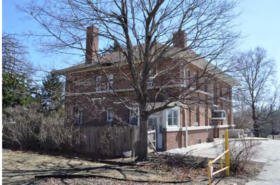
6_Assoc Wardens Res_View SSE.JPG
