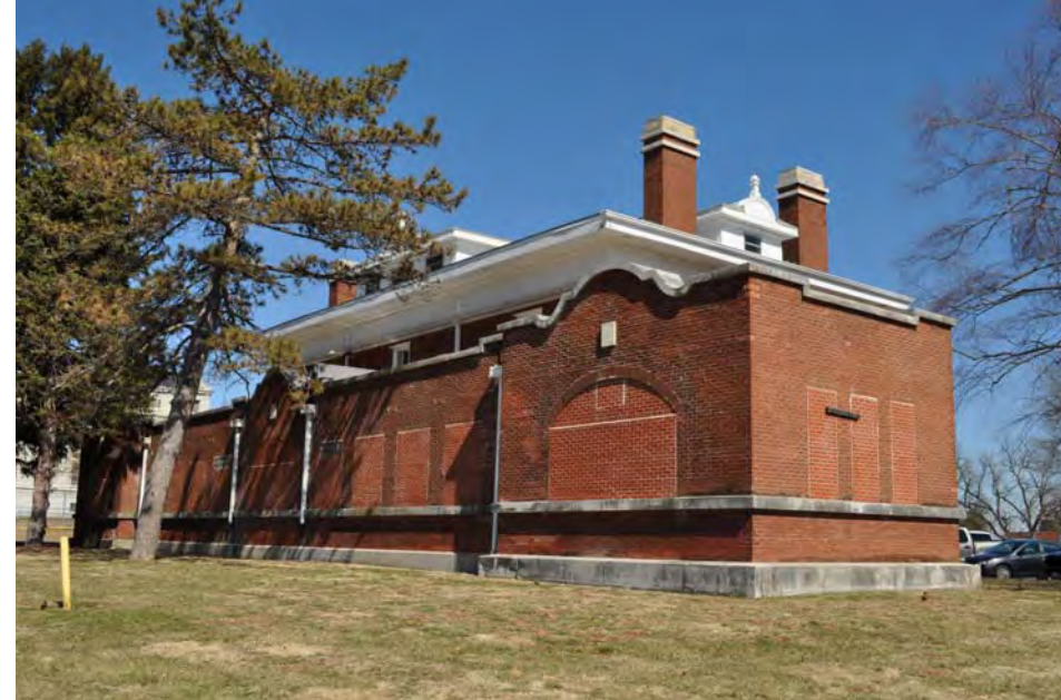
2_Bachelor Quarters_View NE.JPG
