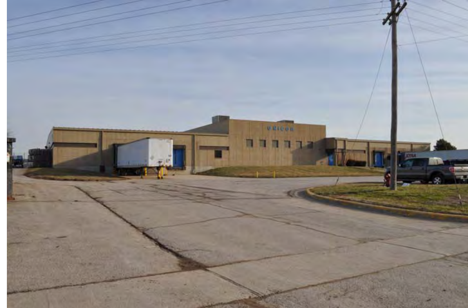
38_Unicor Building_View NNE.JPG
