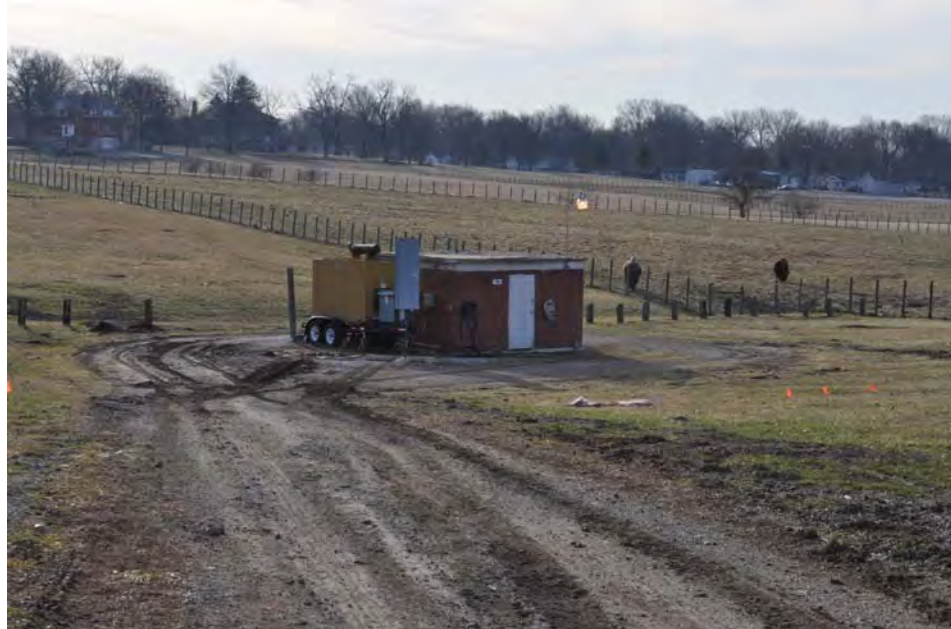
45_Pump House_View SE.JPG
