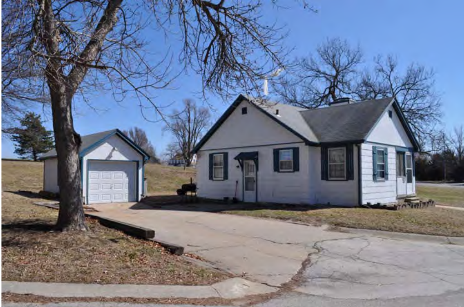
15_1028 Metropolitan Ave_View SE.JPG
