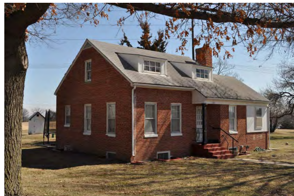
26_812 Metropolitan Ave_View SE.JPG
