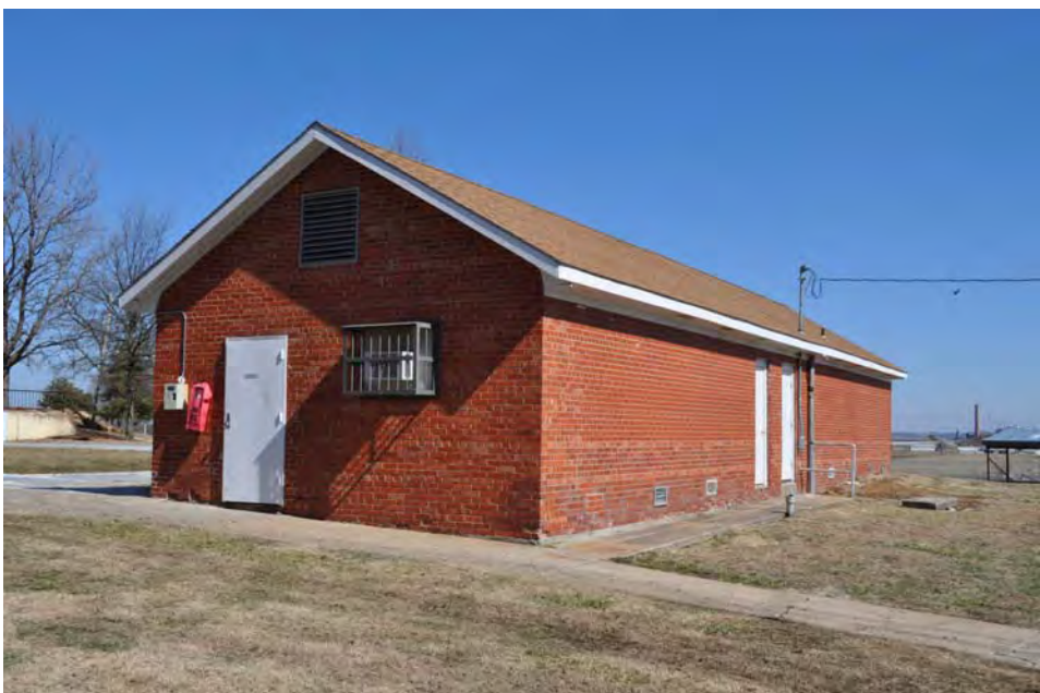
49_Toilet Block_View NE.JPG
