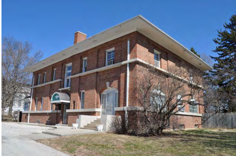
6_Assoc Wardens Res_View NE.JPG
