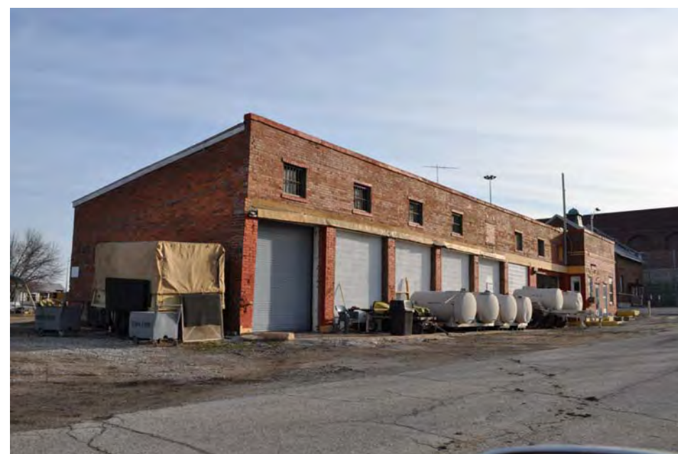
43_Old Garage_View NE.JPG
