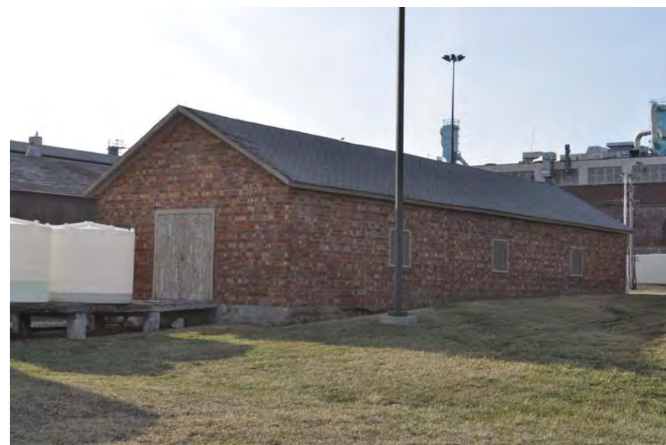
32_Cement Storage_View SE.JPG
