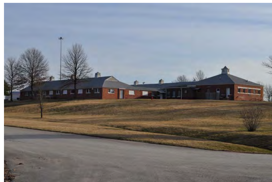
40_Dairy Barn_View NE.JPG
