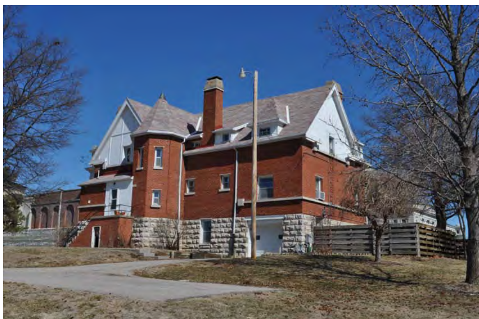
7_Assoc Wardens Res_View NE.JPG
